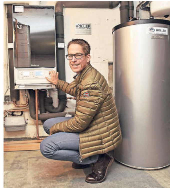
Behagliche Wärme ist garantiert: In nur fünf Tagen tauschte die Heinrich Holler GmbH eine Öl- gegen eine Gasheizungsanlage aus.
