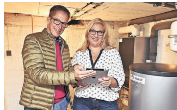
Am Ende gibt Carsten Holler noch eine Einweisung in das neue System, das ganz auf das individuelle Heizverhalten der Hauseigentümer abgestimmt ist.
